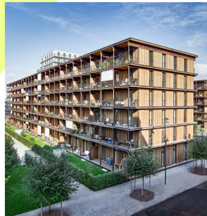
Dans le cadre de sa stratégie de durabilité, AXA évalue les possibilités de mettre en place des installations photovoltaïques dans l'ensemble de son portefeuille immobilier.
