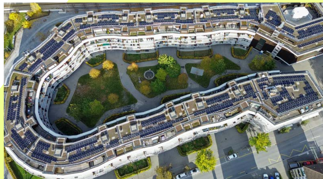
Bâtiment Pulvermühle d'AXA à Coire: le toit accueille 504 panneaux photovoltaïques pour la production d'électricité.
