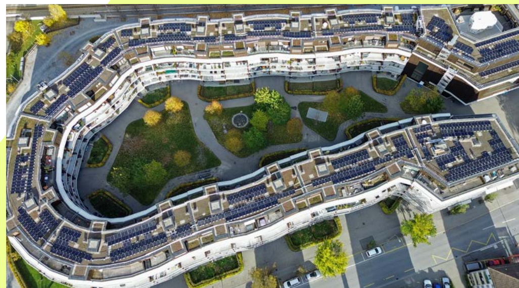
Complesso Pulvermühle realizzato da AXA a Coira: sul tetto sono montati 504 pannelli fotovoltaici per la produzione di energia elettrica.
