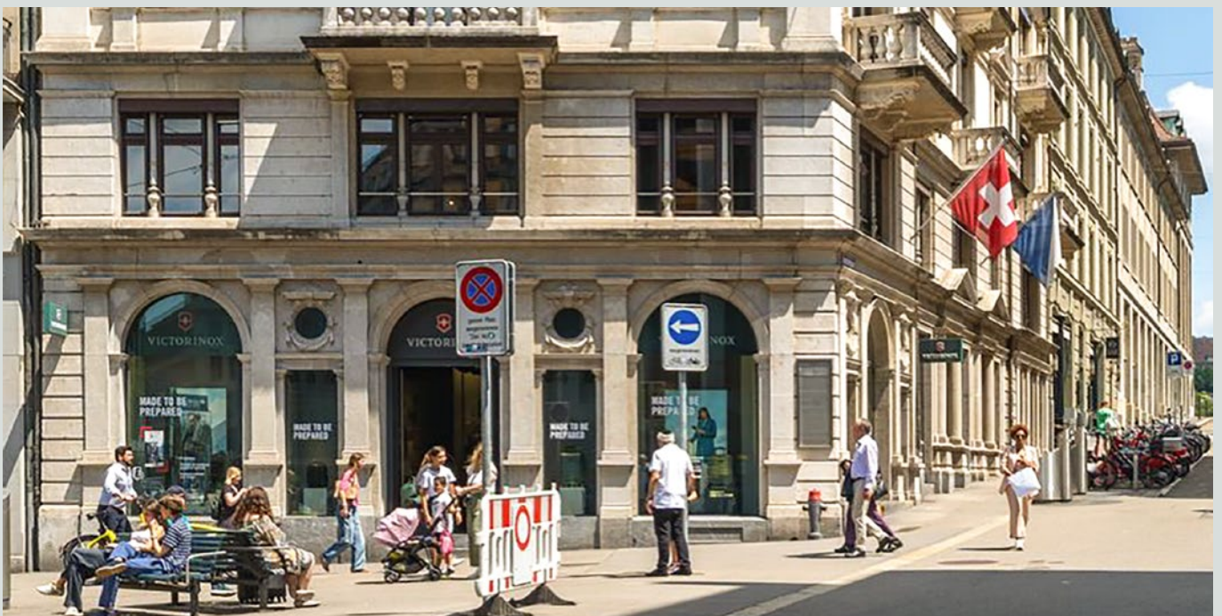
Zürich (ZH) | Haus «Herkules» Rennweg 58 / Oetenbachgasse 26
